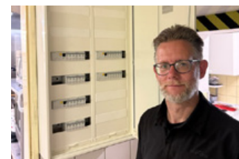
Unser Kerngeschäft: Die klassische Elektroinstallation
